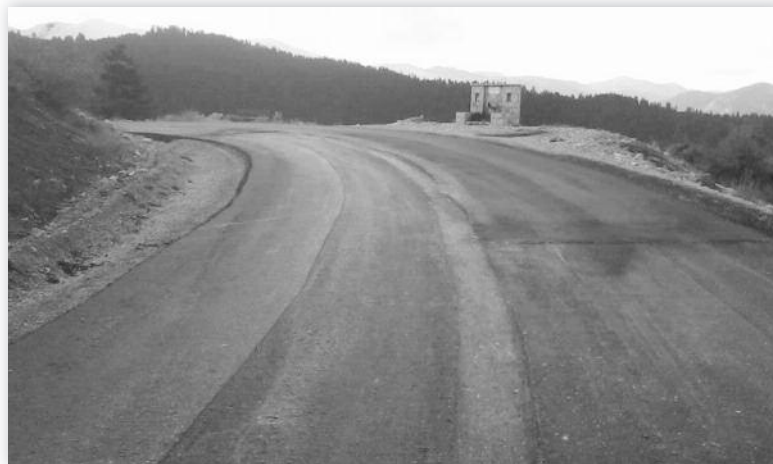
Στο Νεχώρι ο δρόμος έφτασε στα πρώτα σπίτια του χωριού
