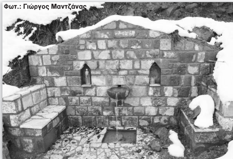
Η ανακατασκευή της Κουτόβρυσης
